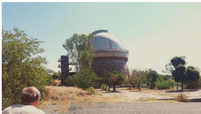
Fot. 10. Budynek i kopuła 2,6m reflektora Cassegraina
